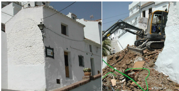
Demolición de casas-patrimonio en La Zerbará.
