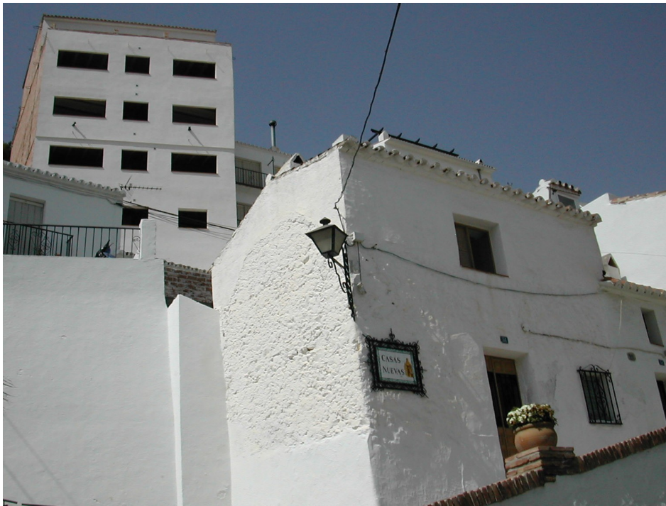
Contraste entre la fachada derruida de la casa nº 56 y los nuevos edificios que se vienen construyendo.
